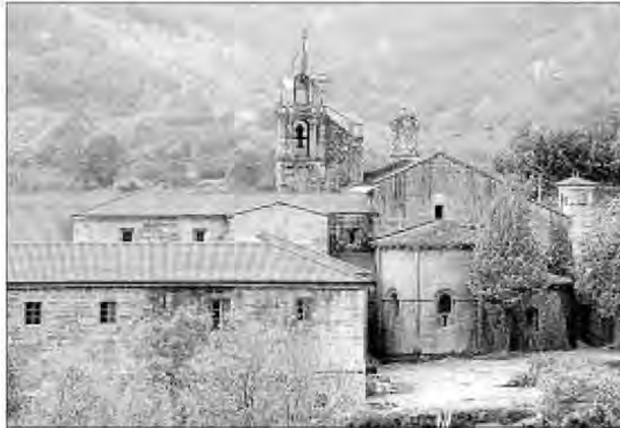
Las obras de rehabilitación del viejo cenobio cisterciense comenzaron en 1997
