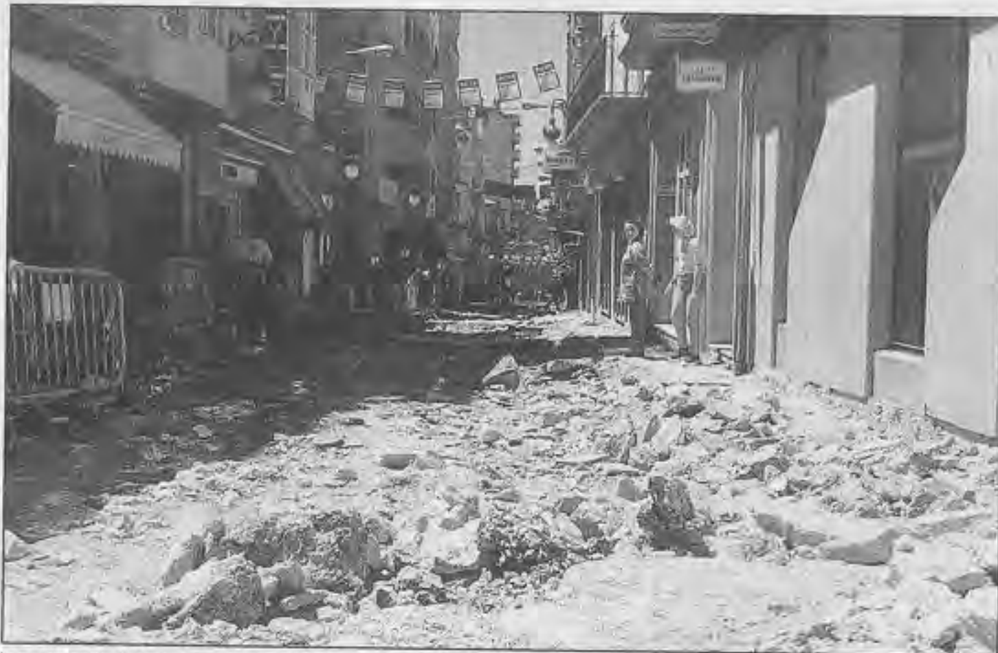
Aspecto actual que presentan as obras da rúa Principal
