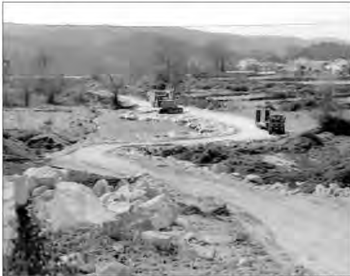
El BNG considera que el impacto más grave de la obra es su incidencia en el centro escolar
