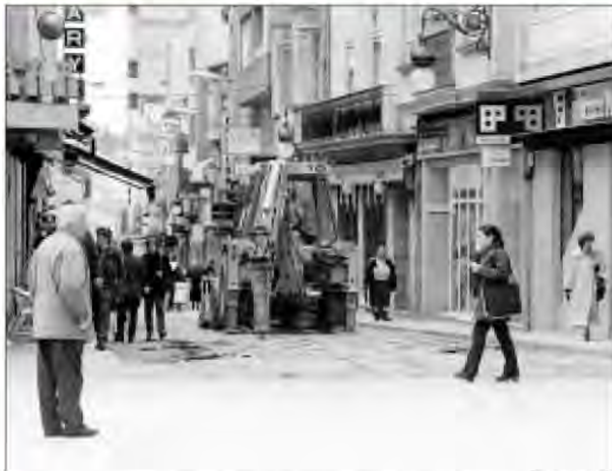
La brigada de obras empezó ayer a levantar el asfalto
