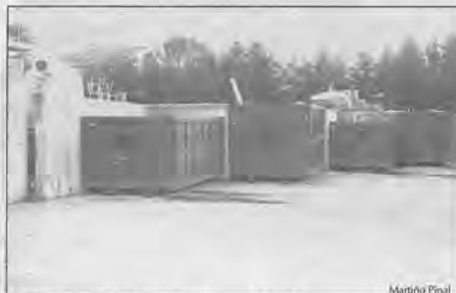
Instalaciones del Punto Limpio, en A Medela.
